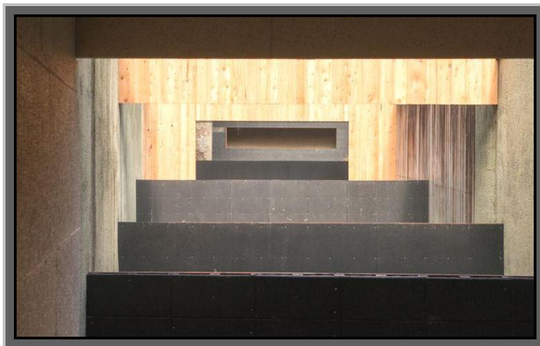
Bild 1: Bodenblenden auf einem Schießstand
